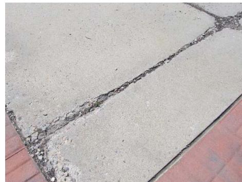
Spalling
